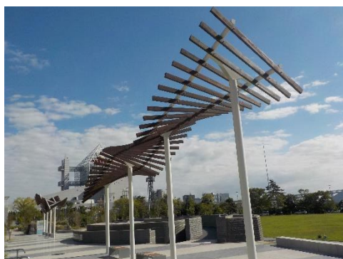
ビレッジプラザの木材を活用した パーゴラ（日除け施設）（晴海ふ頭公園）
