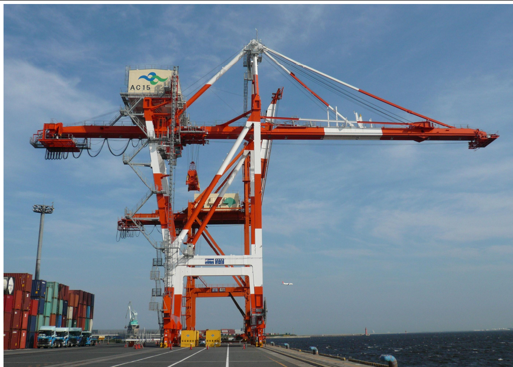
写真 新コンテナクレーン(AC15号)
