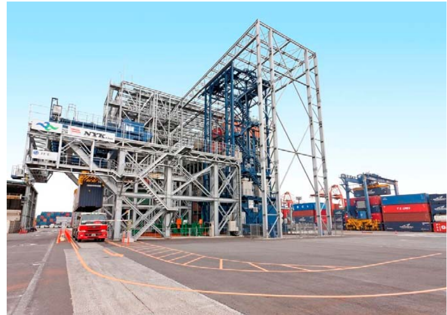
立体格納庫外観
