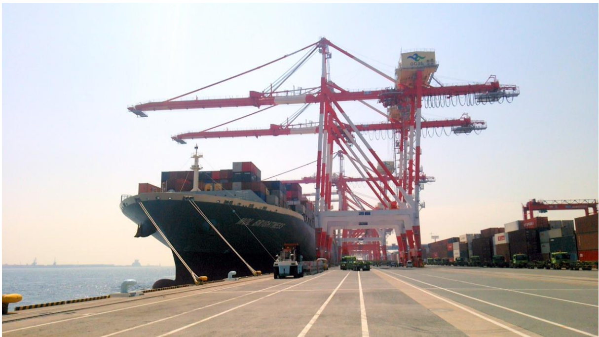
写真 新コンテナクレーン（OC36号機、OC37号機、OC38号機）
