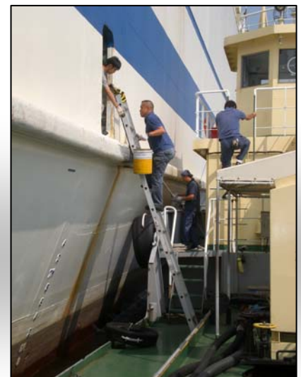
廃油回収作業
