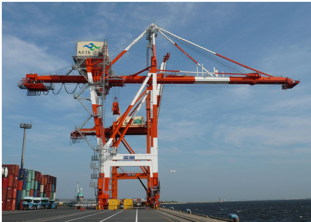
写真 新コンテナクレーン(AC15号)
