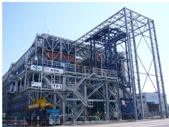
（立体格納庫 外観）
